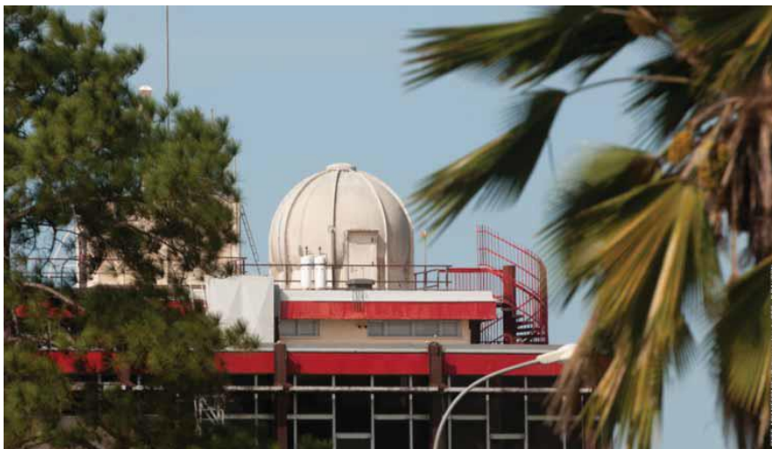
Station Télécommande / Sauvegarde
