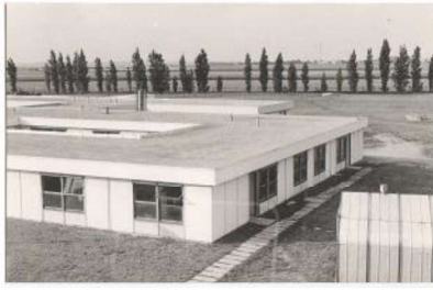
Bâtiment Abbé Pierre - Centre Spatial de Brétigny
