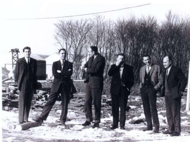
Fondation du Centre Spatial de Brétigny en 1963
